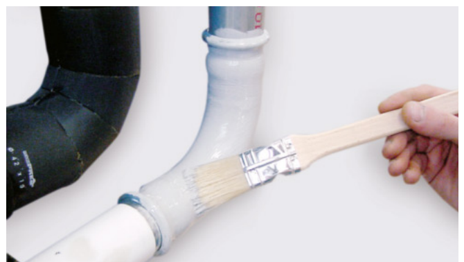
Bild 37 – Anstricharbeiten von Anschlussstücken und Rohrleitungen mit Grundierung
