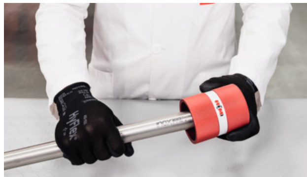
Bild 26 - Entgraten des Leitungsrohres
