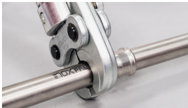
Bild 32 – Herstellen der Pressverbindung
