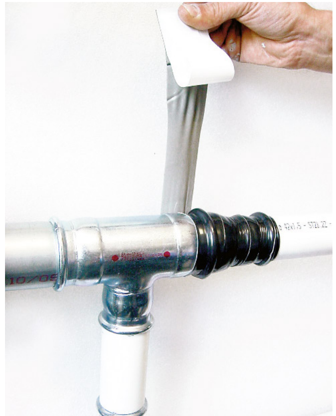
Bild 38 – Schutz der Anschlüsse mit Butanolklebeband.
