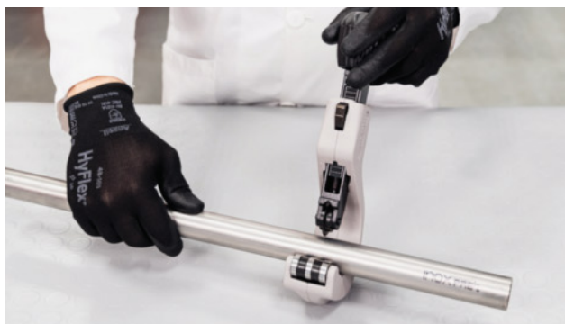
Bild 25 - Ablängen des Leitungsrohres
