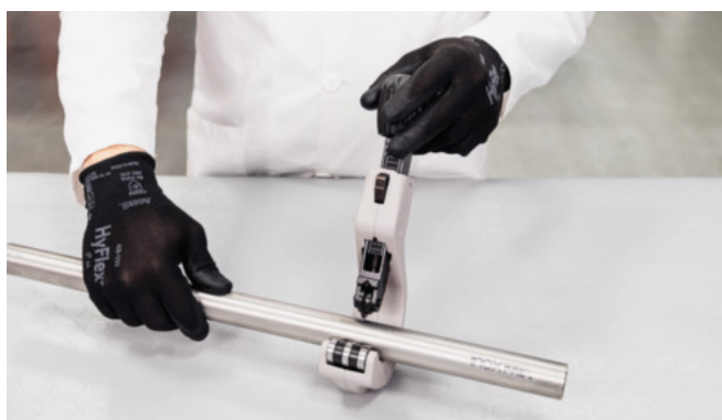
Image 25 - Mise à longueur des tubes
