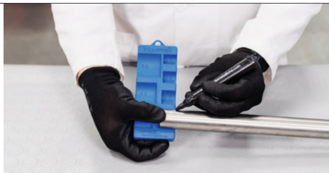
Image 28 - Marquage de la profondeur d'emboîtement
