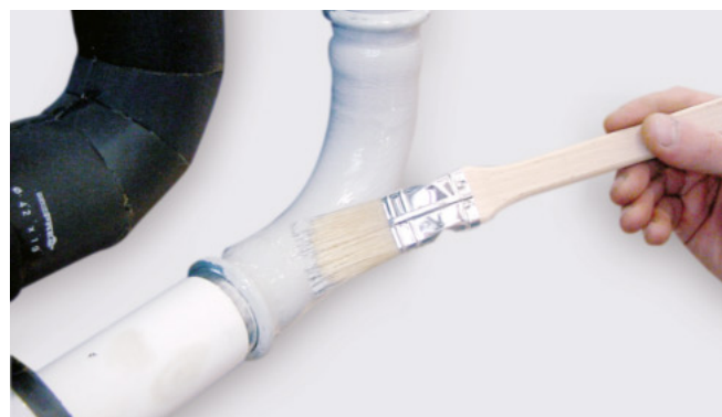
Image 37 - Application du vernis primaire sur les conduites avec enduit
