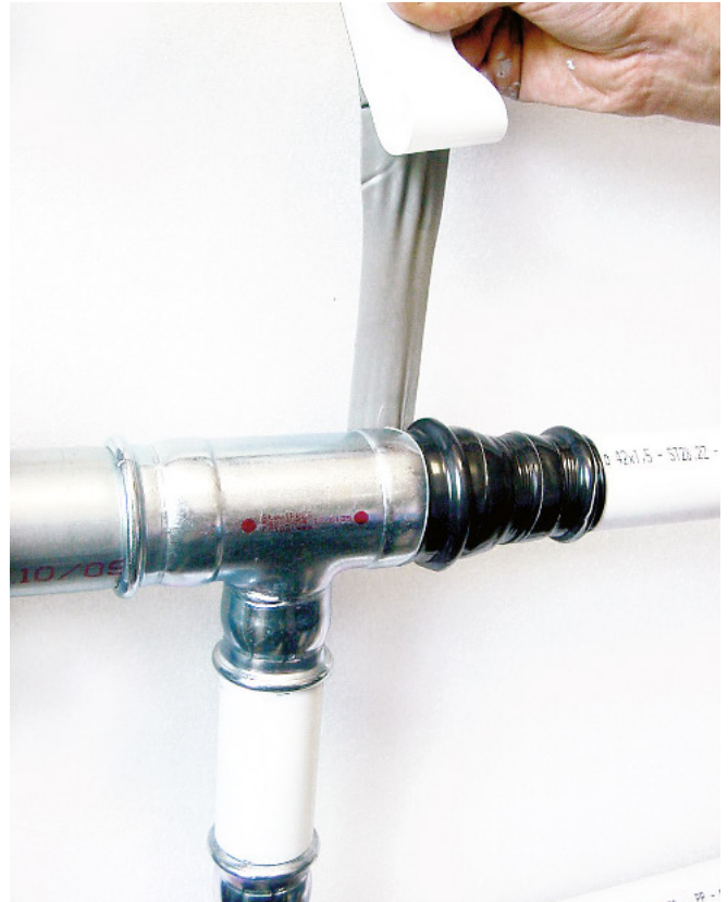
Image 38 - Protection des raccordement avec la bande adhésive
