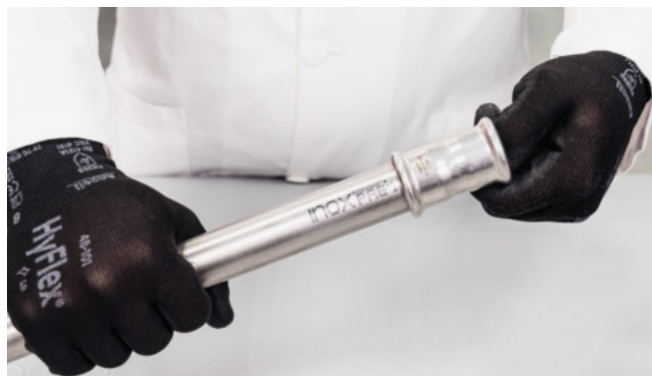
Image 31 - Introduction du tube dans le raccord
